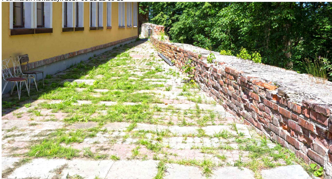
Fot.14. Stan muru w czerwcu 2017 roku – zapadnięcie powierzchni terenu.
