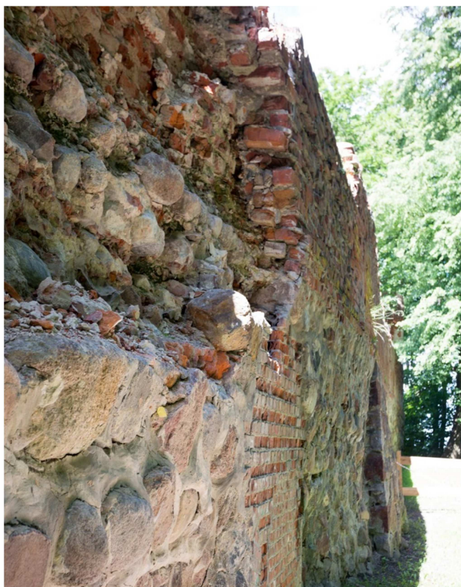
Fot.09. Stan muru po awarii w czerwcu 2017 roku. Znaczny ubytek.
