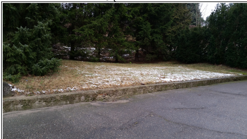
Nawierzchnia asfaltowa przy północnej ścianie bryły „B” - do zerwania i utylizacji, zamknięta betonowym murkiem (rozbiórka). W tle widoczne drzewa do wycinki.
