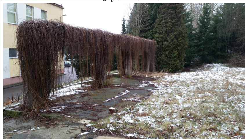
Pergola betonowa, teren na skarpie wraz z betonową płytą na gruncie (do rozbiórki)
