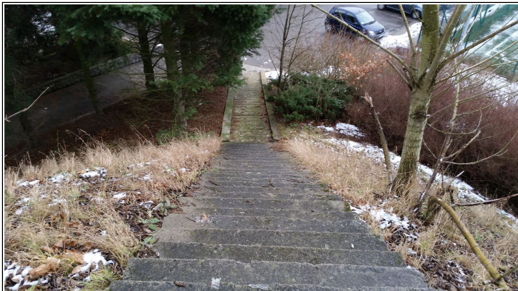
Betonowe schody prowadzące do „znicza olimpijskiego” - do rozbiórki w całości, poniżej widoczne murki betonowe
