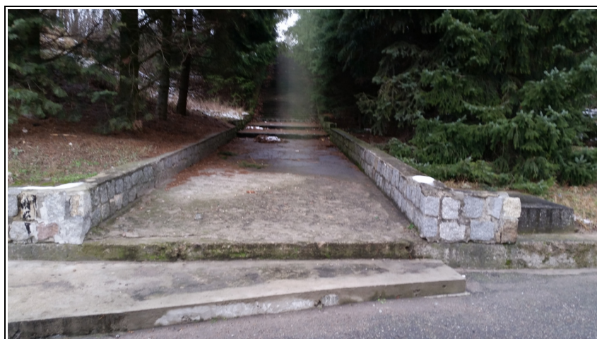
Te same schody widoczne od dołu biegu, wraz z betonowymi płytami na gruncie
