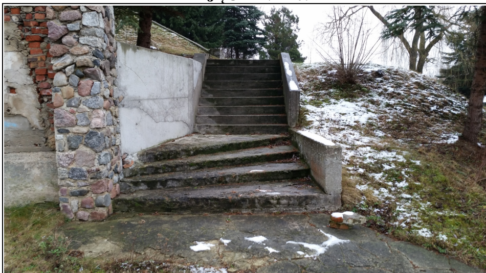
Betonowe schody (do rozbiórki w całości) prowadzące do amfiteatru (do zasypiania) Po prawej stronie widoczny ceglany mur oporowy.
