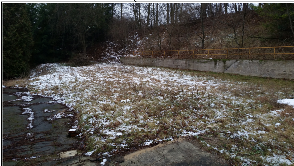
Teren na skarpie, zamknięty betonowym murkiem oporowym (do rozbiórki wraz z poręczami)
