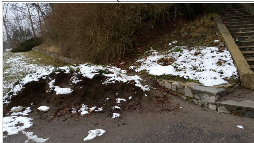
Murek betonowy prowadzący od schodów na „znicz olimpijski” wzdłuż boiska sportowego - do rozebrania w całości
