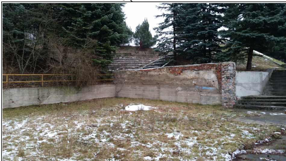
W tle widoczny amfiteatr do zasypania urobkiem, po prawej stronie betonowe schody do rozbiórki, na pierwszym planie ceglany mur oporowy i ściana oporowa z poręczami (wszystkie elementy do usunięcia i utylizacji)
