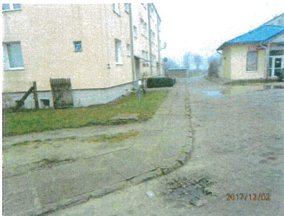
Zdjęcie 5 (budynek nr 21)
