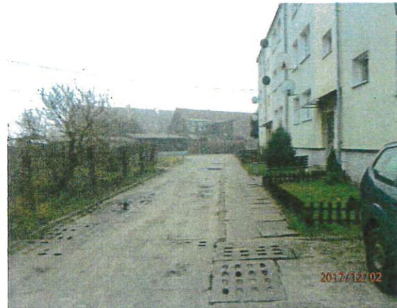
Zdjęcie 4 (budynek nr 20)
