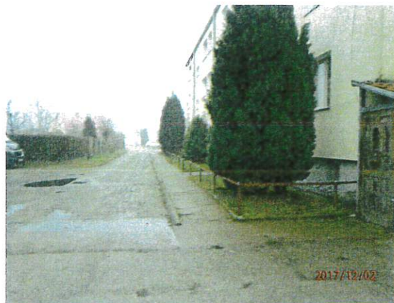
Zdjęcie 8 (budynek nr 22)
