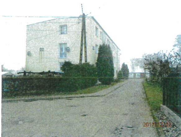
Zdjęcie 7 (budynek nr 22)
