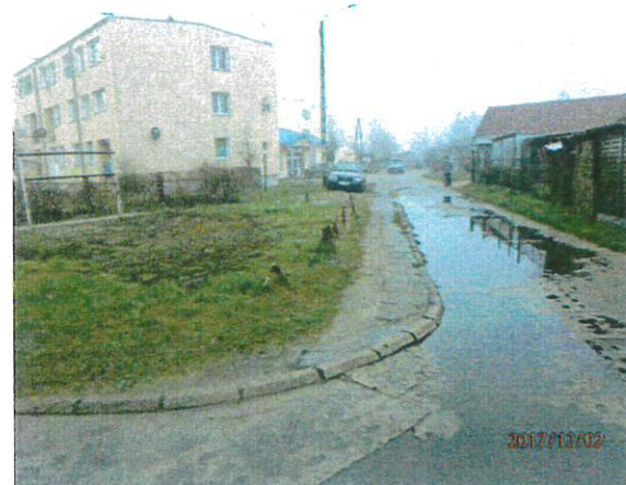
Zdjęcie 6 (budynek nr 21)
