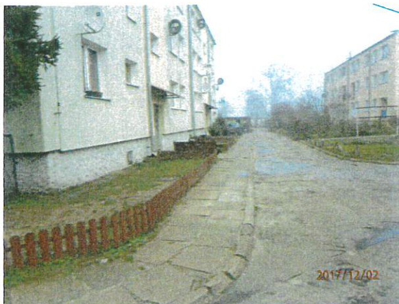
Zdjęcie 3 (budynek nr 20)
