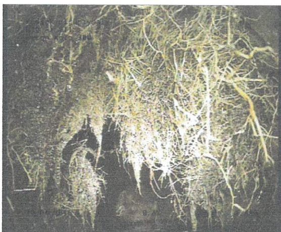
Zdjęcie: 13_2A 1,5m, Złożona masa korzeni, Zmniejszenie przekroju poprzecznego: 35 %, od 10 do 3 godz.
