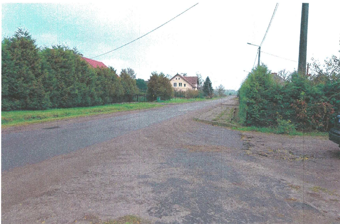
Zdjęcie nr 3 - widoczność w kierunku Pasłęka
