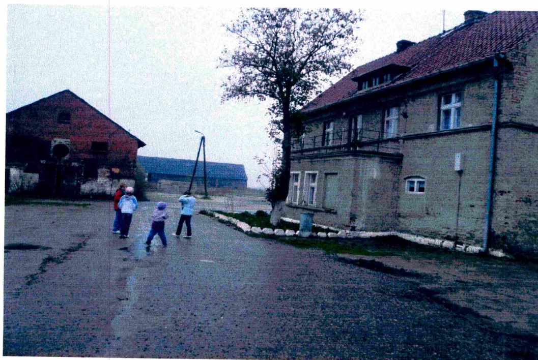
Zaniedbane budynki gospodarcze
