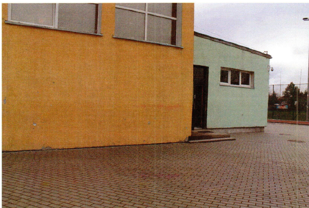
Fot. 1. Budynek szkoły otoczony opaską z polbruku
