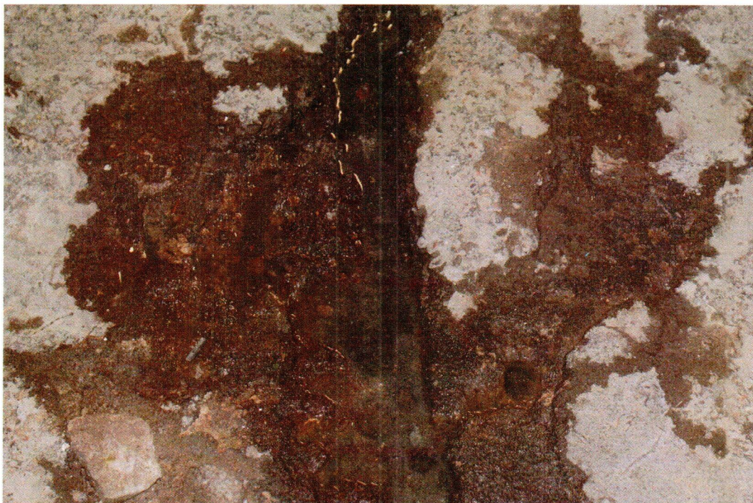
Fot. 13. Spękana i pokruszona posadzka z wydobywającą się wodą
