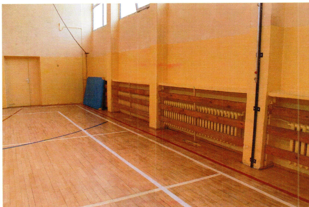
Fot. 8. Sala gimnastyczna – wejście od strony magazynku
