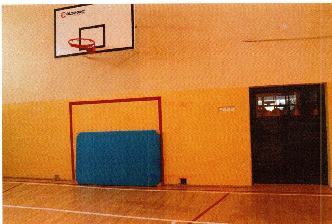
Fot. 7. Wejście do sali gimnastycznej od strony holu
