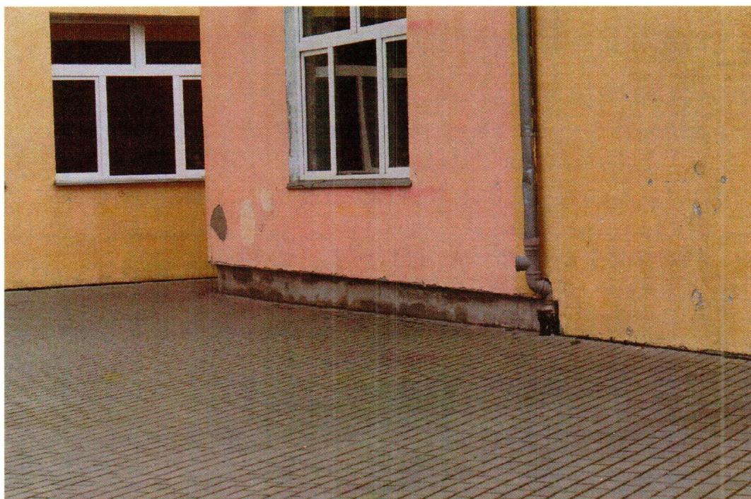
Fot. 2. Ściana boczna sali gimnastycznej z widocznym systemem odwadniającym
